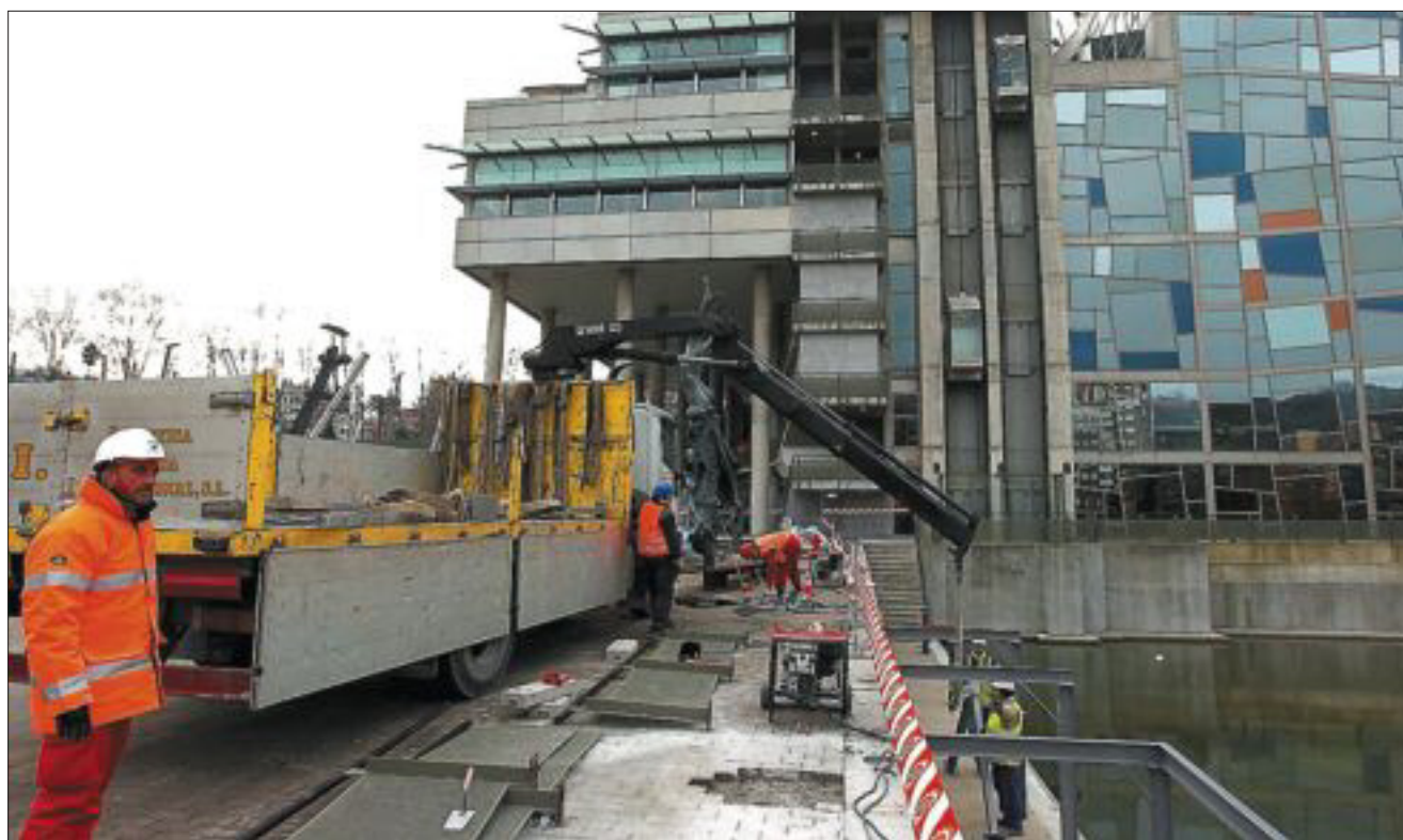
Varios operarios trabajaban ayer en el Palacio Euskalduna de Bilbao. / SANTOS CIRILO
